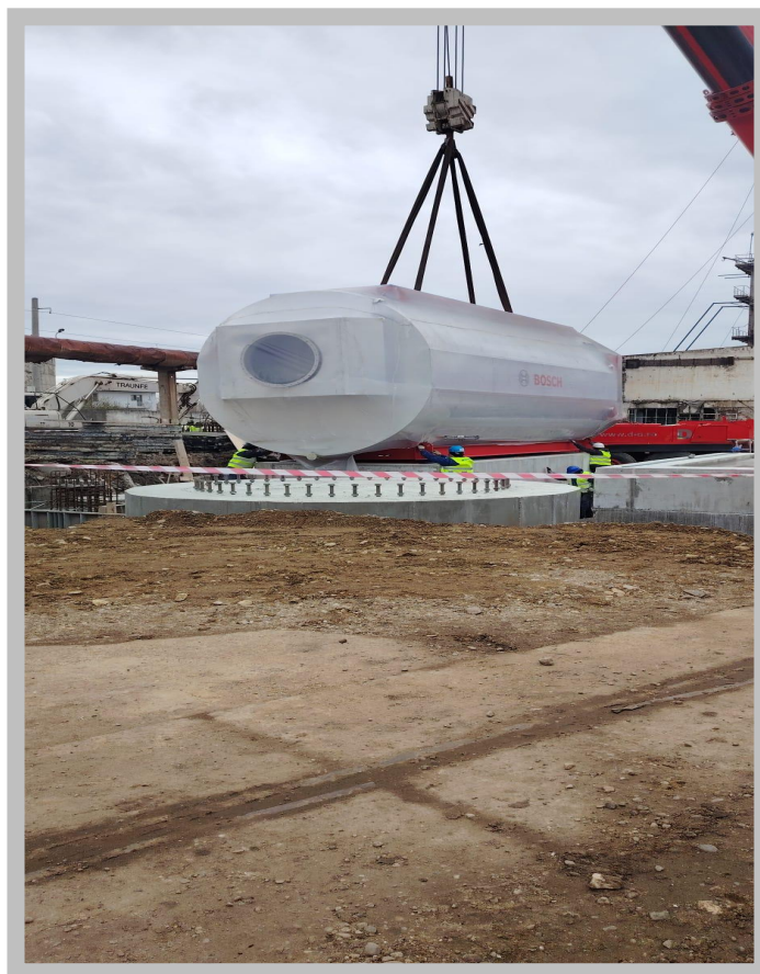
Figura 37. Șantier CET H Arad
